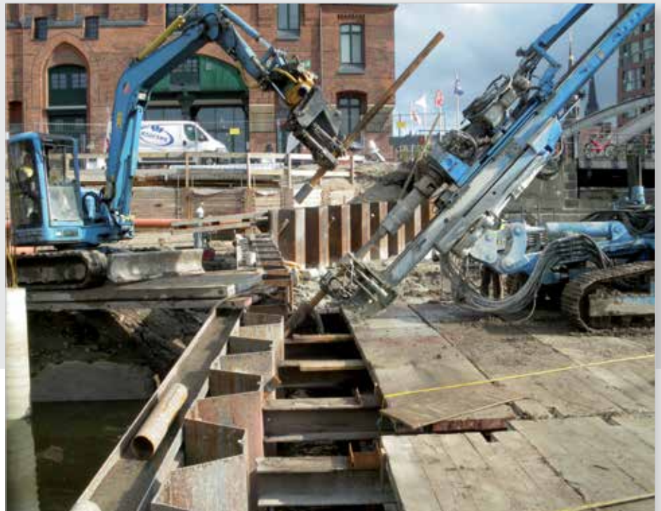
Rückverankerung der Pieranlage Elbtor Magdeburger Hafen, Hamburg
