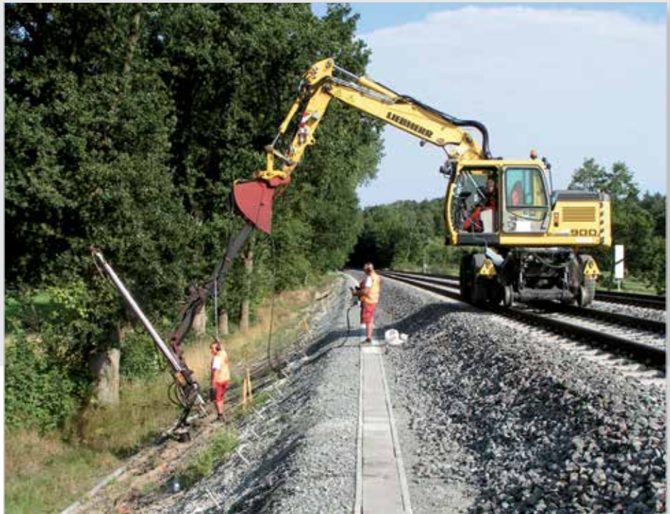
Böschungsvernagelung Ausbaustrecke JadeWeserPort, Wilhelmshaven
