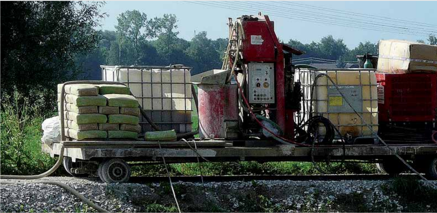
Typische Baustelleneinrichtung bestehend aus Verpresstation und Anbaulafette an der Baumaschine
