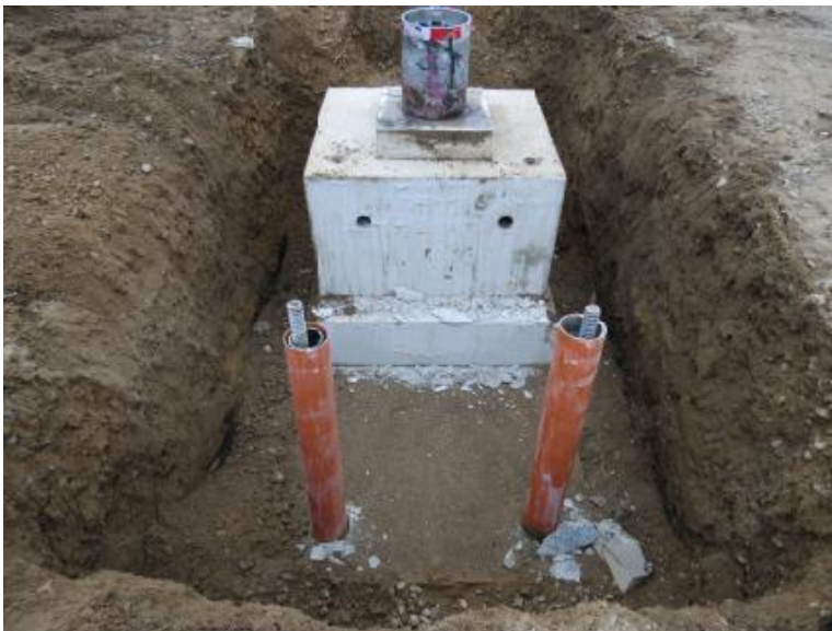
Bild 4: Rückbau nach Crashtest mit unbeschädigten Mikropfählen TITAN 52/26
